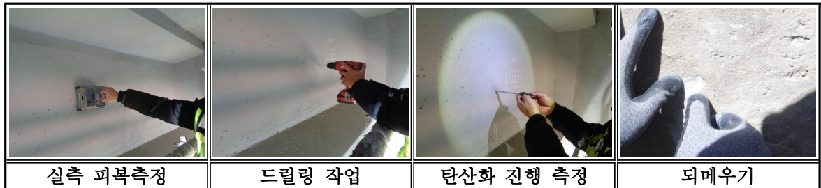
【그림 II-5.3.24】 탄산화 깊이 측정 절차
