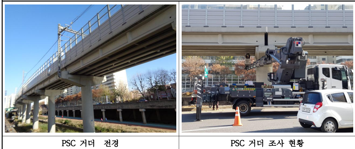
【그림 II-5.3.4】 거더 현황 및 조사 전경
