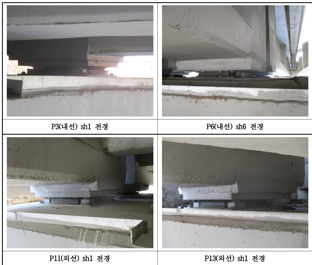
【그림 II-5.3.11】 교량받침 현황 및 조사 전경
