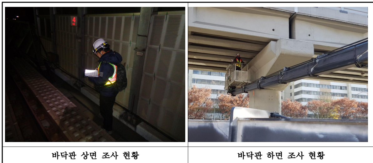
【그림 II-5.3.1】 바닥판 현황 및 조사 전경
